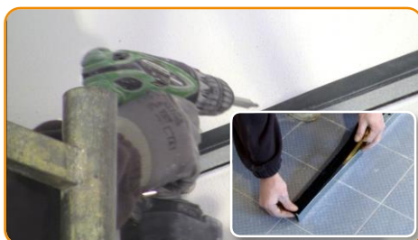
SUFITY Przyklej taśmę samoprzylepną na metalowej ramie
