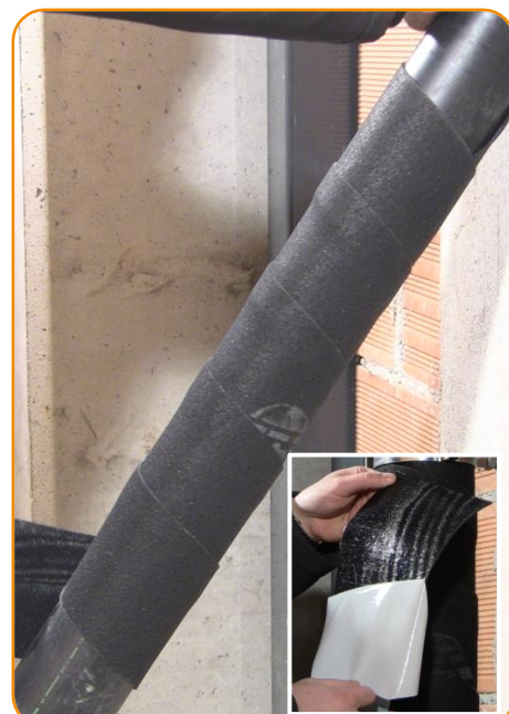
RURY IZOLACJE Usuń samoprzylepną folię i przyklej produkt wokół rur
